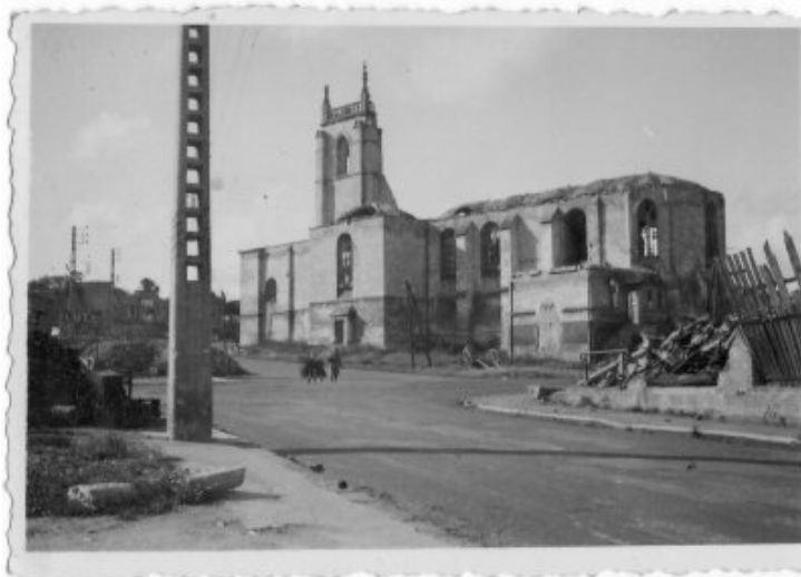
La collégiale irrémédiablement endommagée après les bombardement de juin 1940
